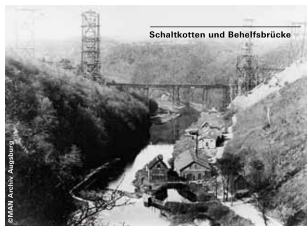
Schaltkotten und Behelfsbrücke
